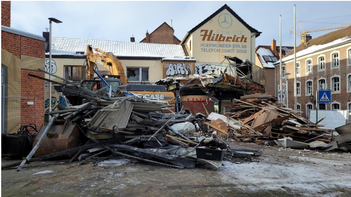
Abbruch, Teil 1: Das ehemalige Sonnenstudio unter der Bahnbrücke gibt es nicht mehr.
