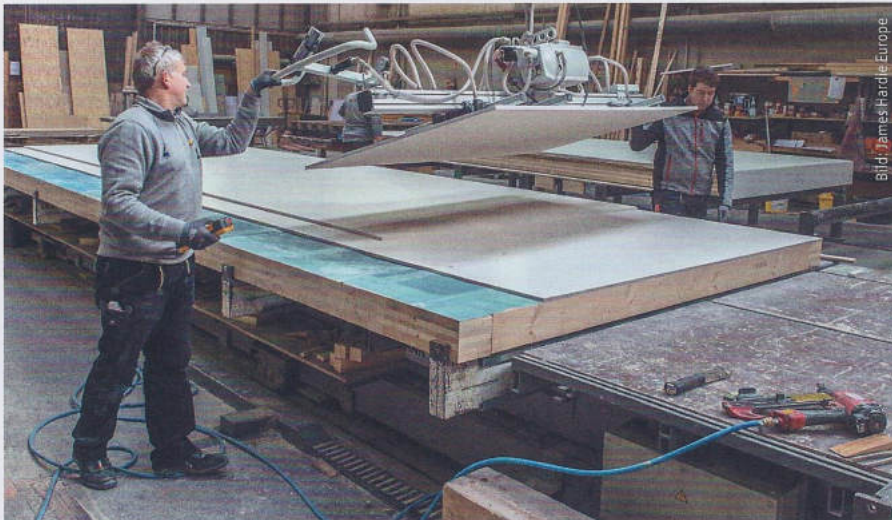
Die zweite Lage Gipsfaser-Platten wird fugenversetzt montiert.
