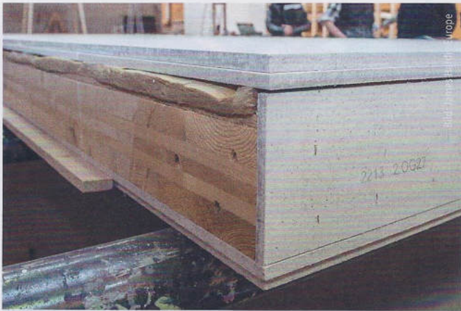
Die Innenwände erhalten beidseitig eine doppelte Beplankung aus 1 x 15 mm und 1 x 18 mm fermacell® Gipsfaser-Platten.
