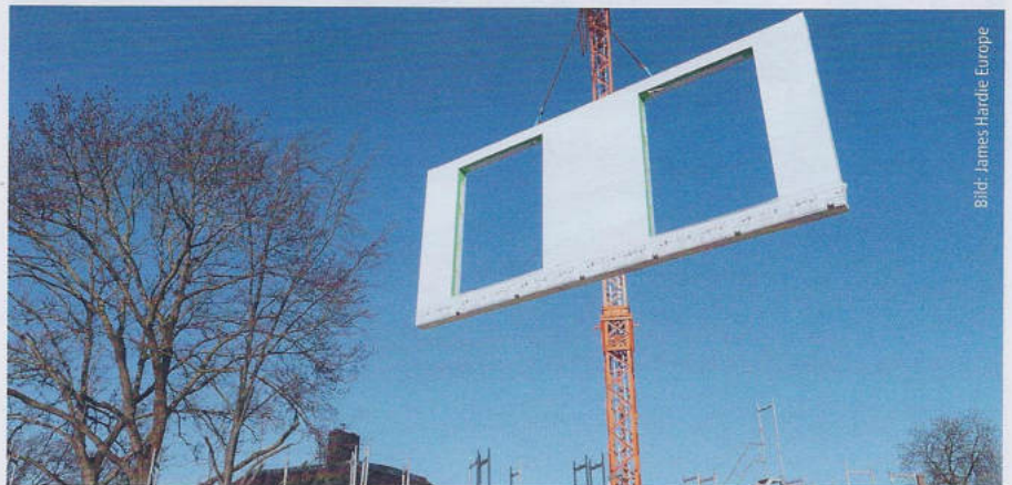
Sämtliche Wände einer jeden Etage konnten innerhalb von nur zwei Tagen montiert werden. Die Wandelemente wurden just in time per Tieflader auf die Baustelle transportiert und sofort vor Ort verarbeitet.
