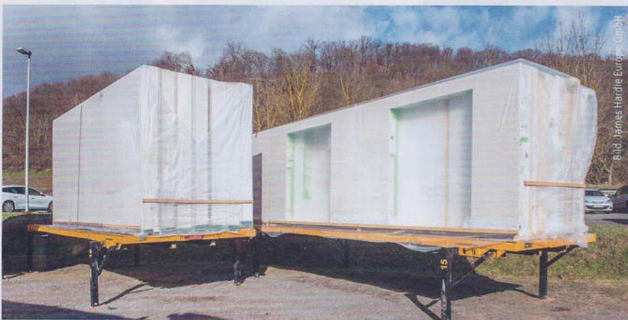
Die Wandelemente sind fertig zum Transport auf die Baustelle. Sie wurden stockwerkweise pünktlich per Tieflader zur Baustelle geliefert, sodass sie sofort montiert werden konnten.
