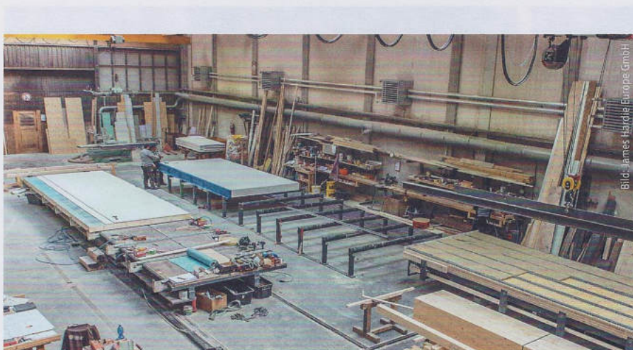
Sämtliche Holztafelelemente wurden unter idealen Bedingungen in den Werkstätten der ADAMS Holzbau-Fertigbau GmbH in Niederzissen vorgefertigt.
