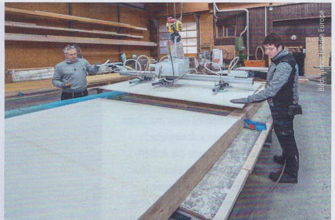
Die erste Lage Gipsfaser-Platten wird im Werk auf die Holzrahmenkonstruktion aufgelegt und mit Klammern befestigt.
